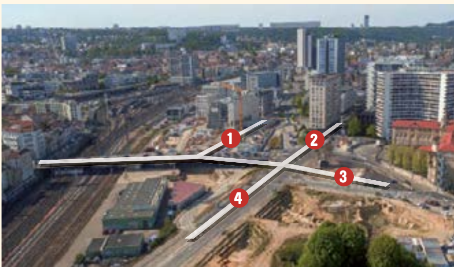
Le Pont des Fusillés raccourci, avec ses nouvelles rues accrochées. Livraison prévue fin 2018.
